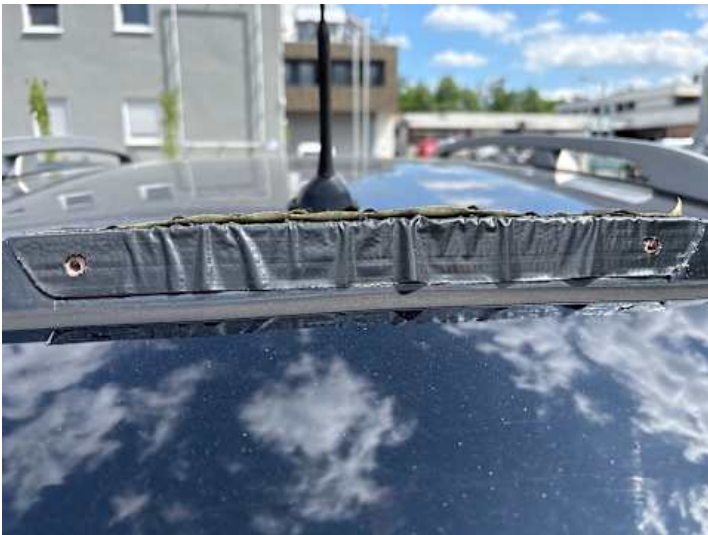
Heckklappe (Riss/Bruch, Unsachgemäß instand gesetzt)
