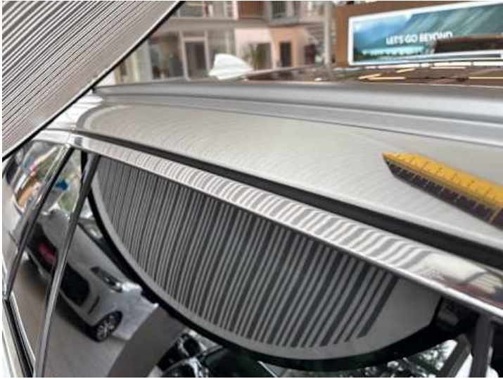
Dach (Unsachgemäß instand gesetzt)
