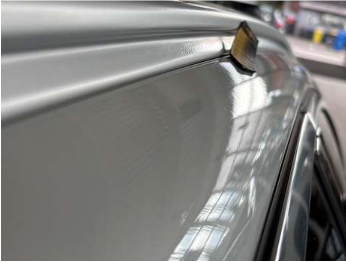
Dach (Unsachgemäß instand gesetzt)
