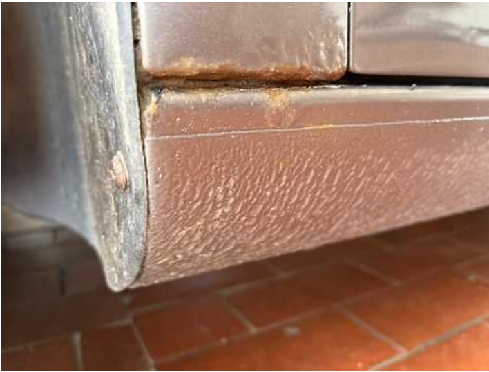
Schweller links (Rost)
