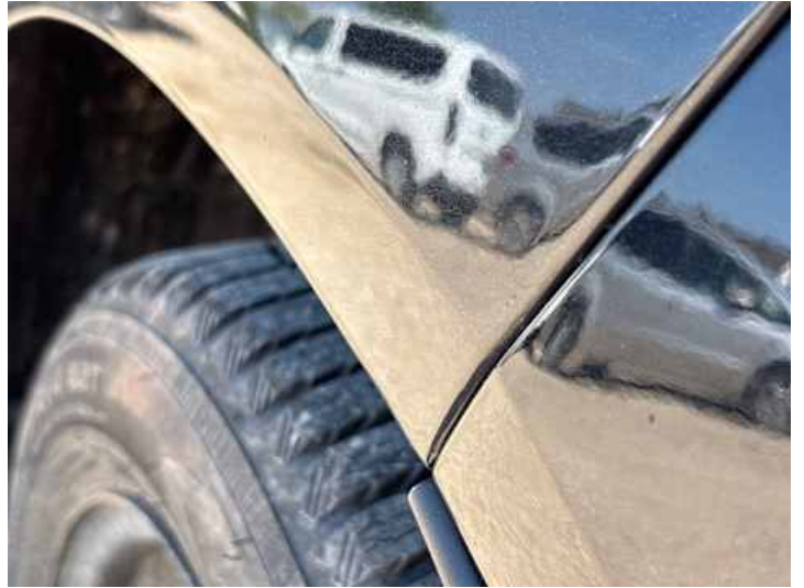
Seitenteil hinten links (Rost)
