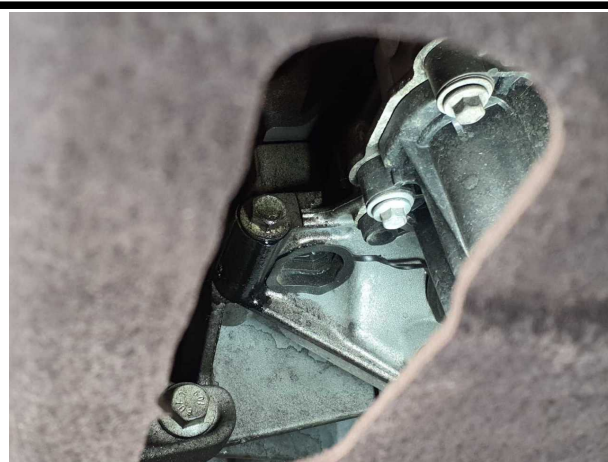
Beschädigung #18: Motor: Motor (Werkstattprüfung erforderlich, Mehrkosten möglich) - undicht - befunden ggf. instandsetzen
