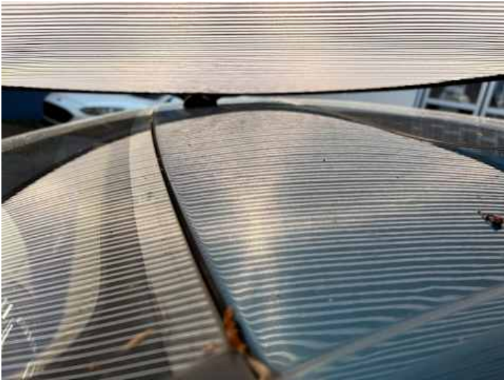
Dach (Delle)
