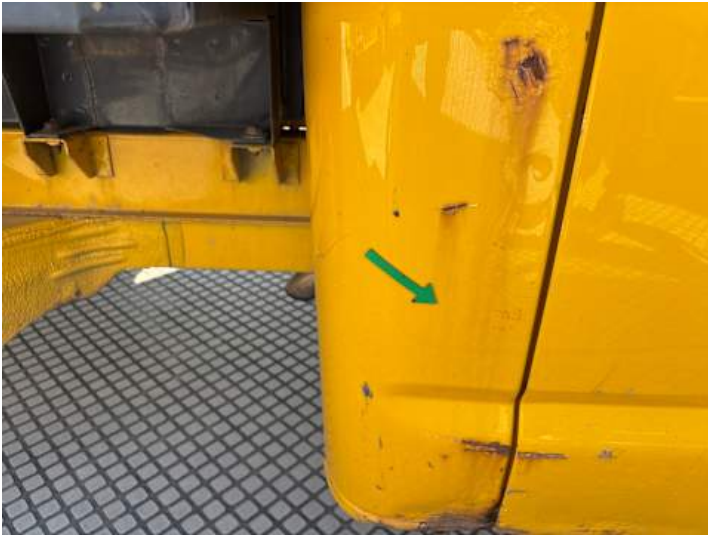
Seitenteil hinten rechts (Rost)
