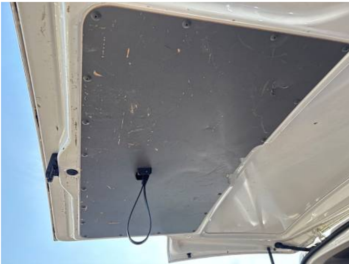
Innenraum (Diverse Schäden)
