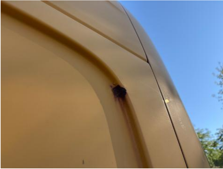
Seitenteil hinten links (Lackschaden, Rost)
