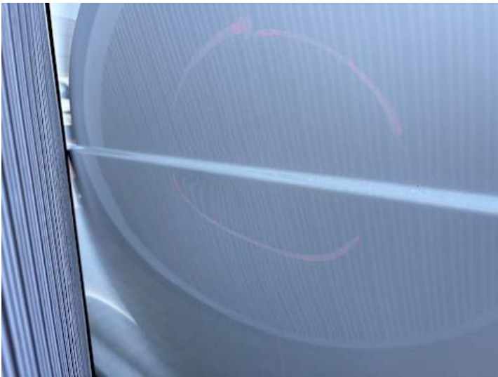
Seitenteil hinten links (Verformung, Delle)
