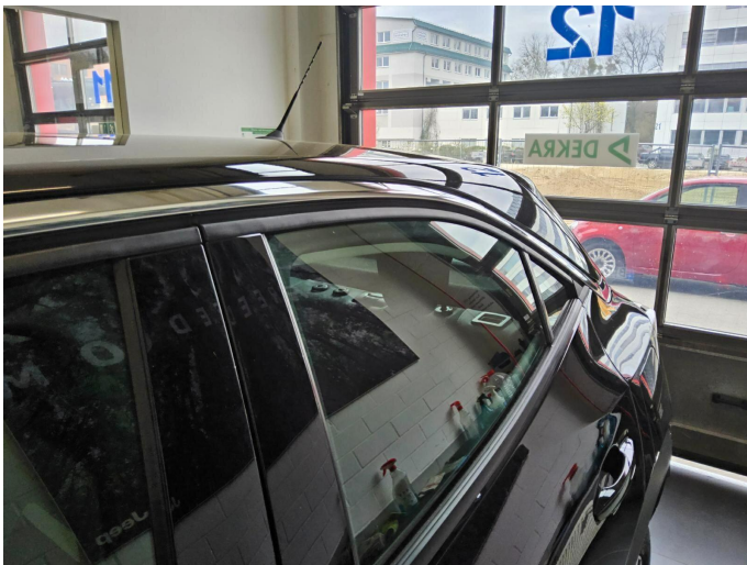
Bild 13: Außen, Dachrahmen links - Chromzierblende , eingedellt, erneuern
