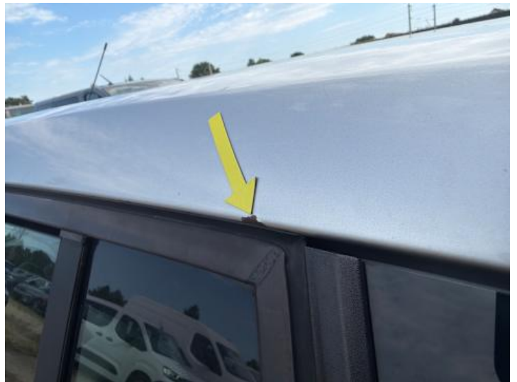
Dach (Rost, Lackschaden)
