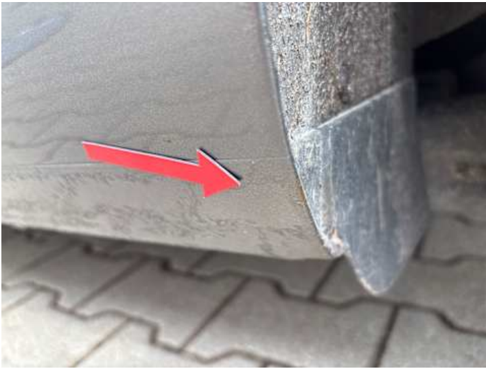
Schweller links (Rost)
