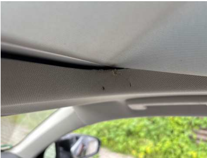
Innenraum (Diverse Schäden)
