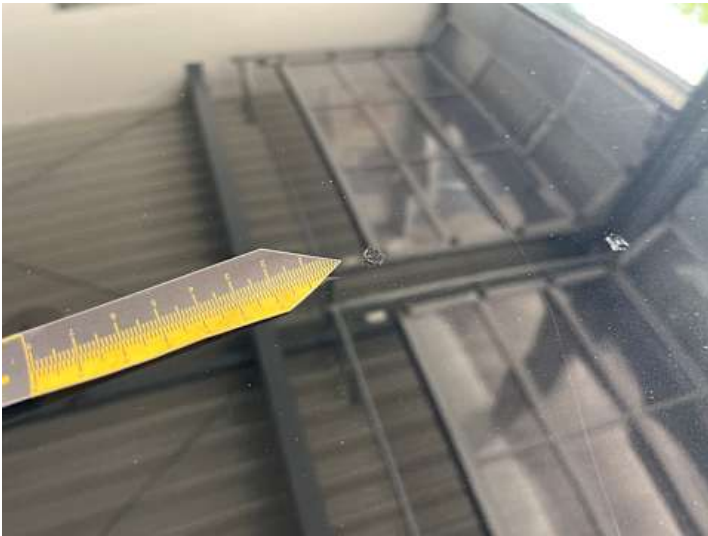
Dach (Lackschaden, Unsachgemäß instand gesetzt)
