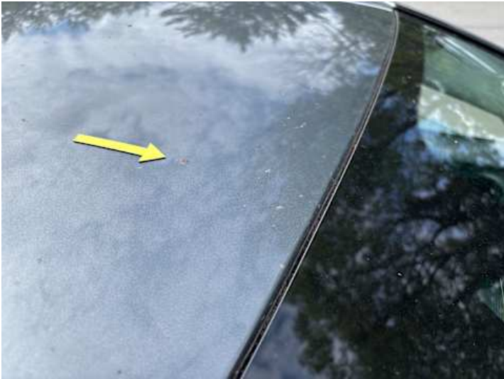
Dach (Kratzer, Rost)
