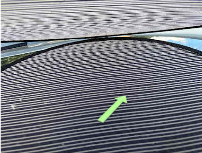
Dach (Lackschaden)
