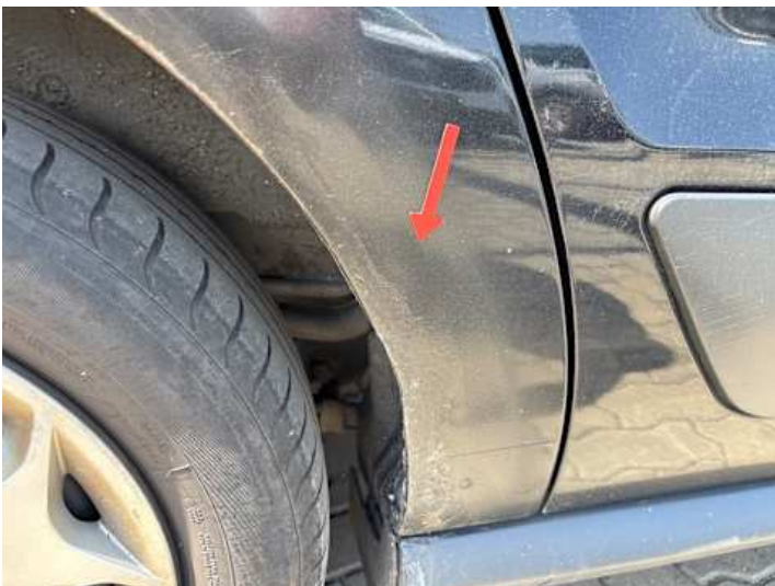
Seitenteil hinten rechts (Rost, Unsachgemäß instand gesetzt, Ausgeblichen/Matt)
