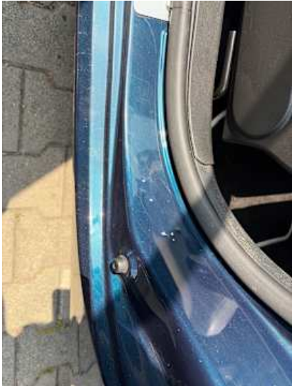
Schweller links (Delle, Kratzer, Lackschaden)
