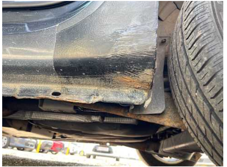
Schweller links (Unsachgemäß instand gesetzt, Rost)
