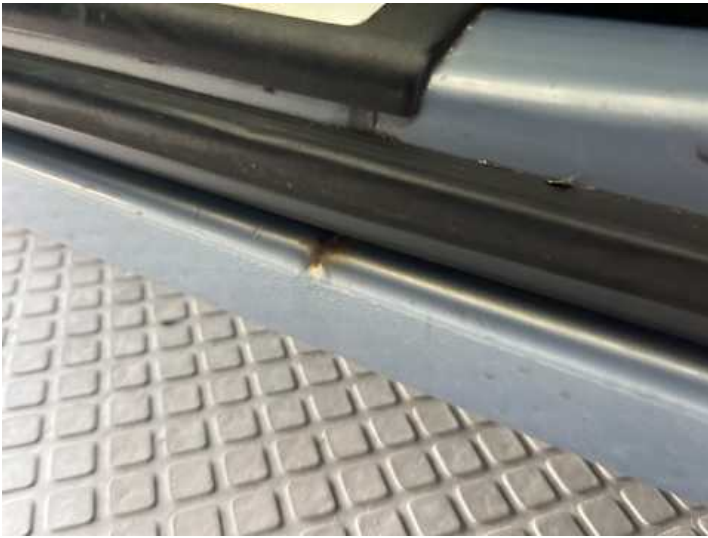
Schweller links (Rost)
