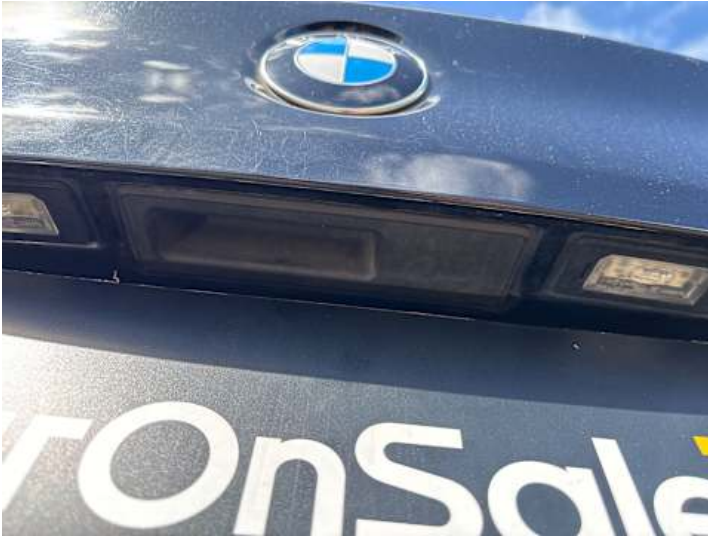
Heckklappe (Kratzer, Anderer Schaden): Kofferraum Öffner defekt
