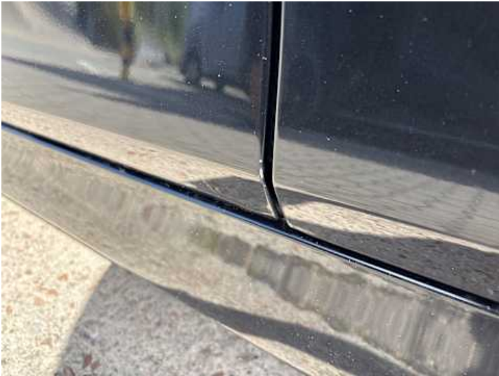
Fahrtür (Lackschaden, Kratzer)
