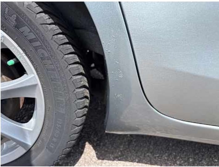
Seitenteil hinten rechts (Spaltmaße ungenau, Rost)
