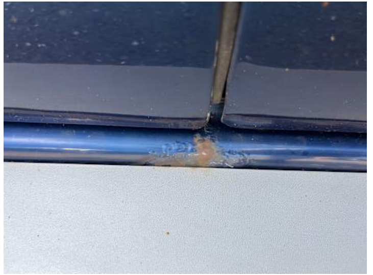
Schweller links (Rost)
