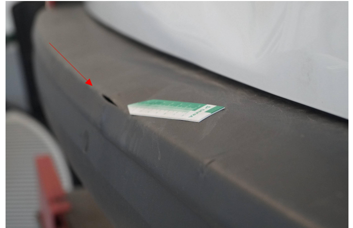
Bild 14: Außen, Stoßfänger hinten, gerissen, erneuern
