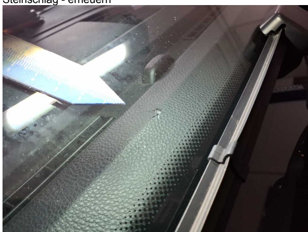
Beschädigung #5: Verglasung: Frontscheibe (Mit Rissbildung) - Steinschlag - erneuern
