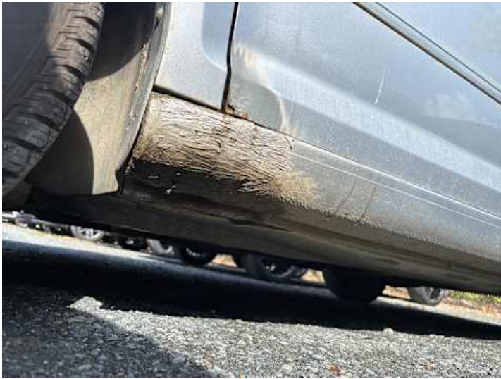
Schweller links (Unsachgemäß instand gesetzt)
