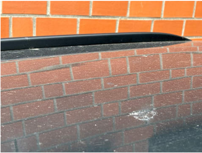
Dach (Delle, Kratzer)
