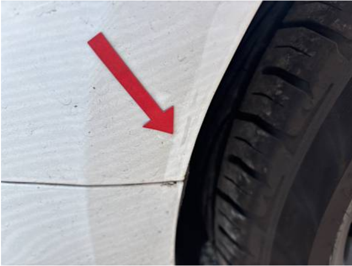
Seitenteil hinten rechts (Rost)
