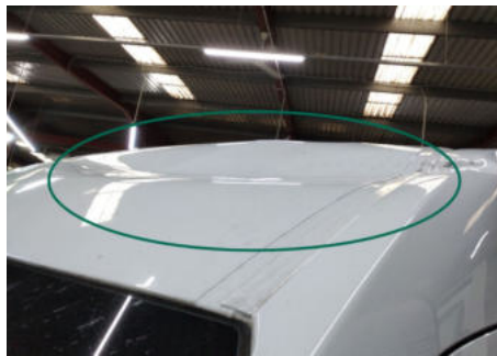
Dach / Vorne / Delle
