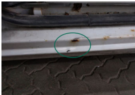
Schweller / Rechts / Delle
