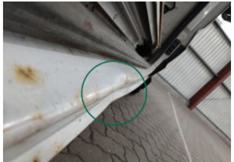
Schweller / Rechts / Delle
