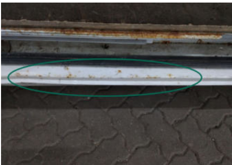
Schweller / Rechts / Delle
