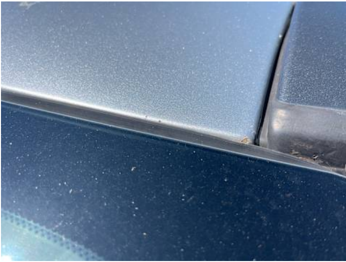
Dach (Steinschlag, Lackschaden)
