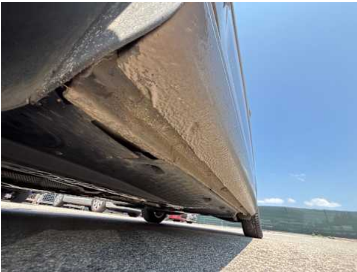
Schweller links (Rost)
