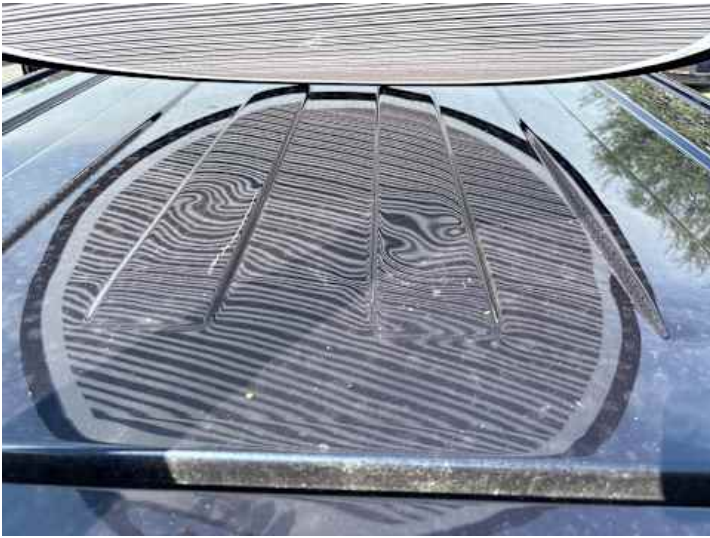
Dach (Verformung, Lackschaden)
