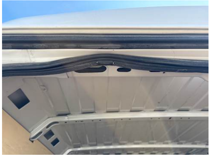
Innenraum (Diverse Schäden)
