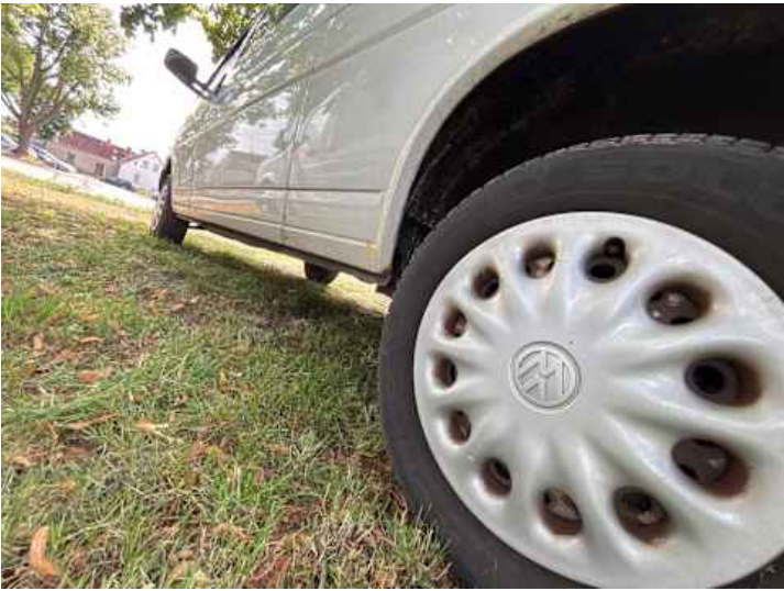
Schweller links (Rost)
