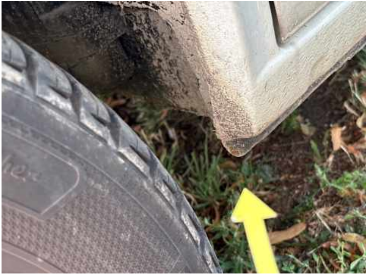
Schweller links (Rost)
