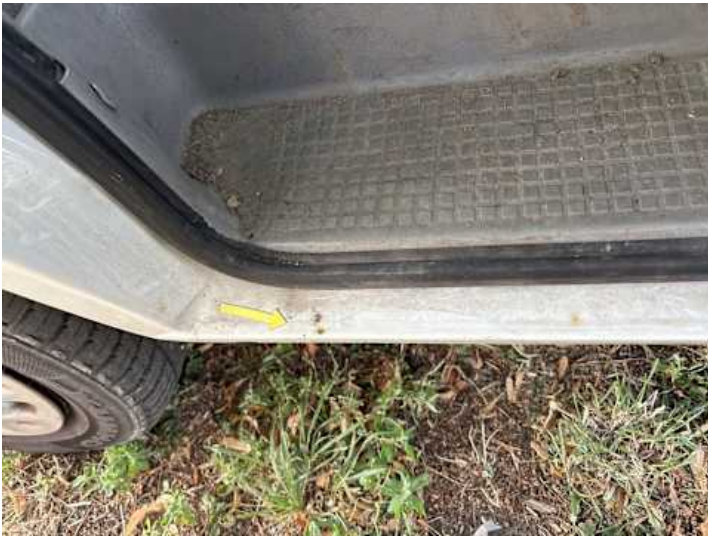
Schweller links (Rost)
