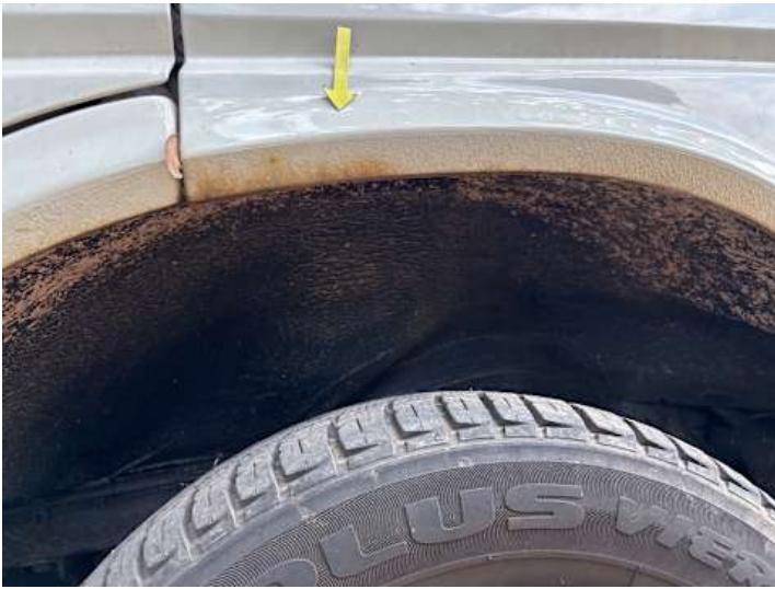
Kotflügel vorne rechts (Rost)
