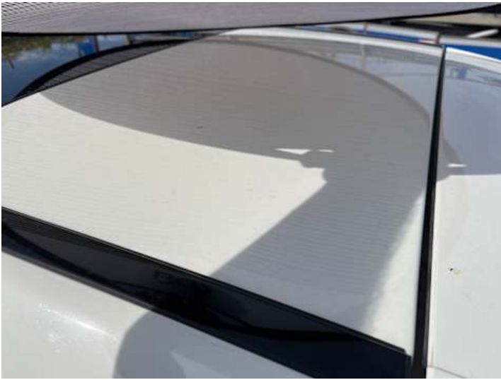
Dach (Lackschaden, Unsachgemäß instand gesetzt)
