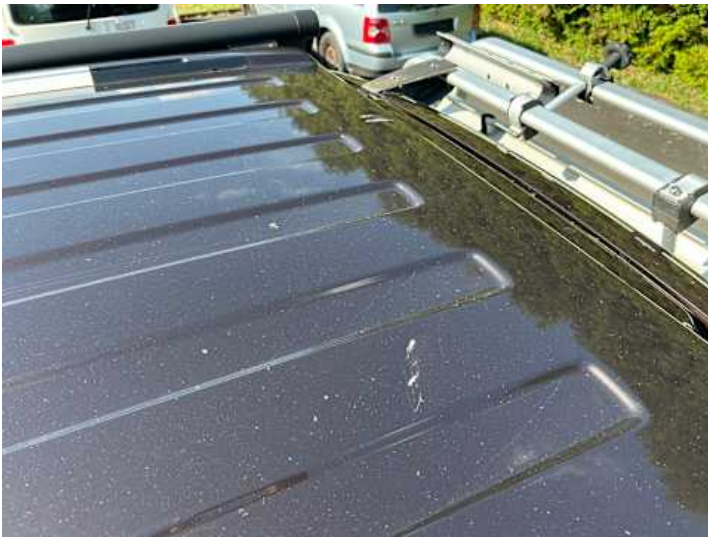
Dach (Kratzer, Verformung)
