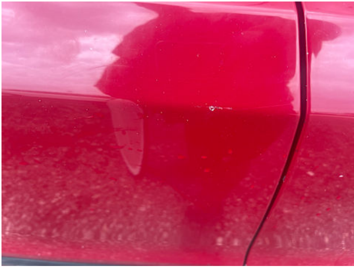
Türe hinten rechts (Kratzer, Lackschaden)
