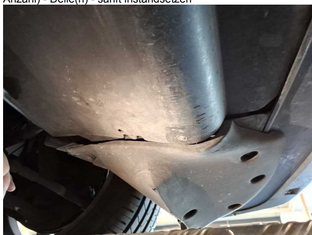
Beschädigung 11: Karosserie: Unterboden - beschädigt
