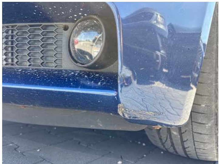
Stoßstange vorne (Riss/Bruch, Kratzer)
