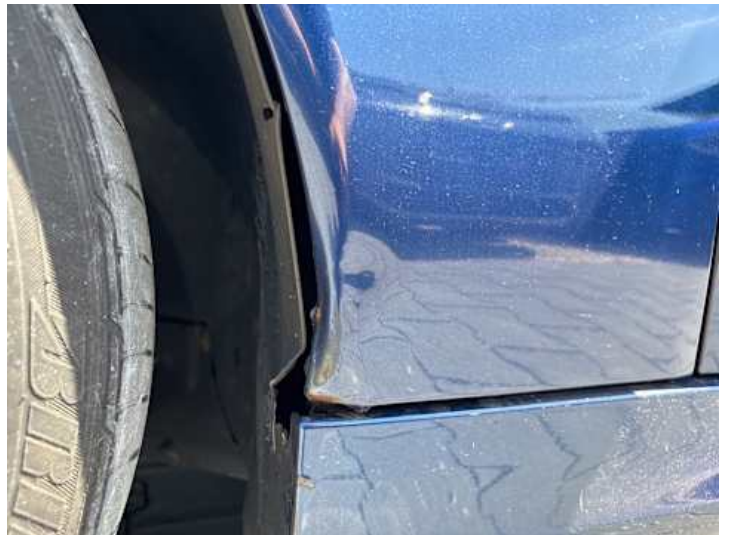
Kotflügel vorne links (Verformung, Rost)
