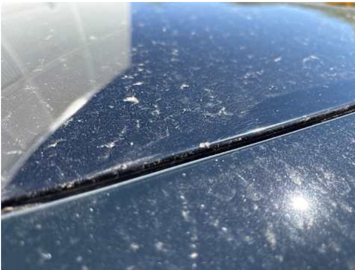
Dach (Rost, Steinschlag)
