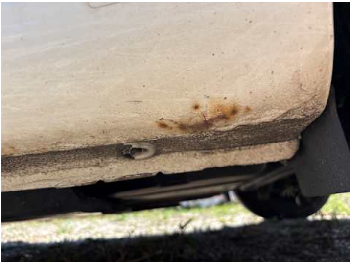
Schweller links (Rost)
