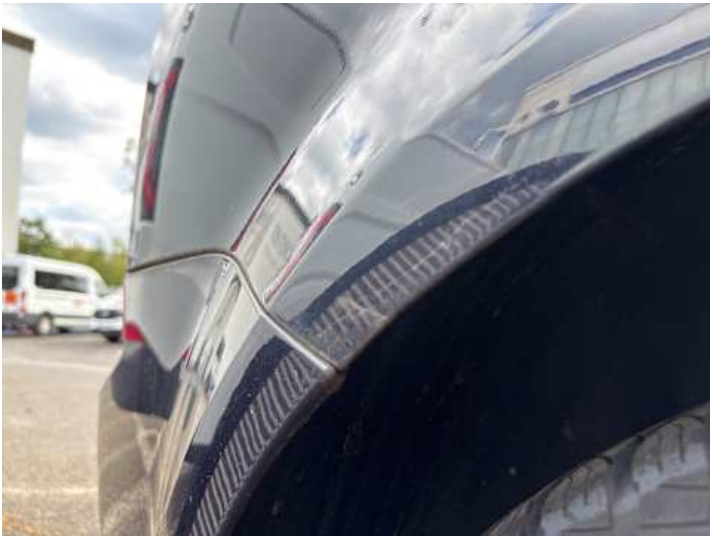
Seitenteil hinten rechts (Rost)
