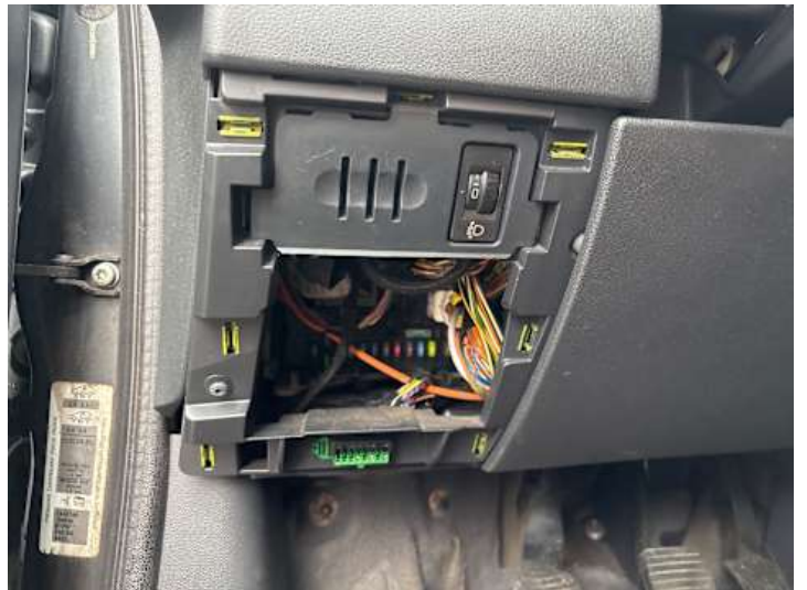
Innenraum (Anderer Schaden): Fehlt
