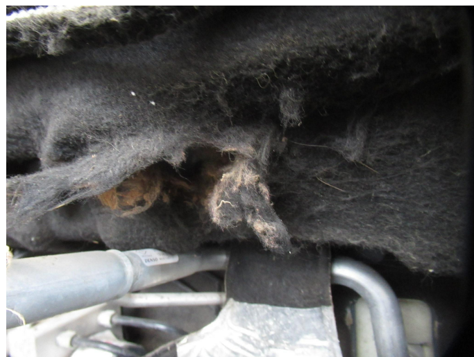
Bild 4: Innen, Motorraum , Tierverschiss, Rep.-Kosten geschätzt (ges. GA erforderlich)
