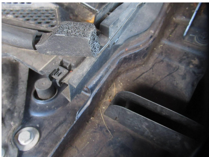
Bild 3: Innen, Motorraum , Tierverschiss, Rep.-Kosten geschätzt (ges. GA erforderlich)
