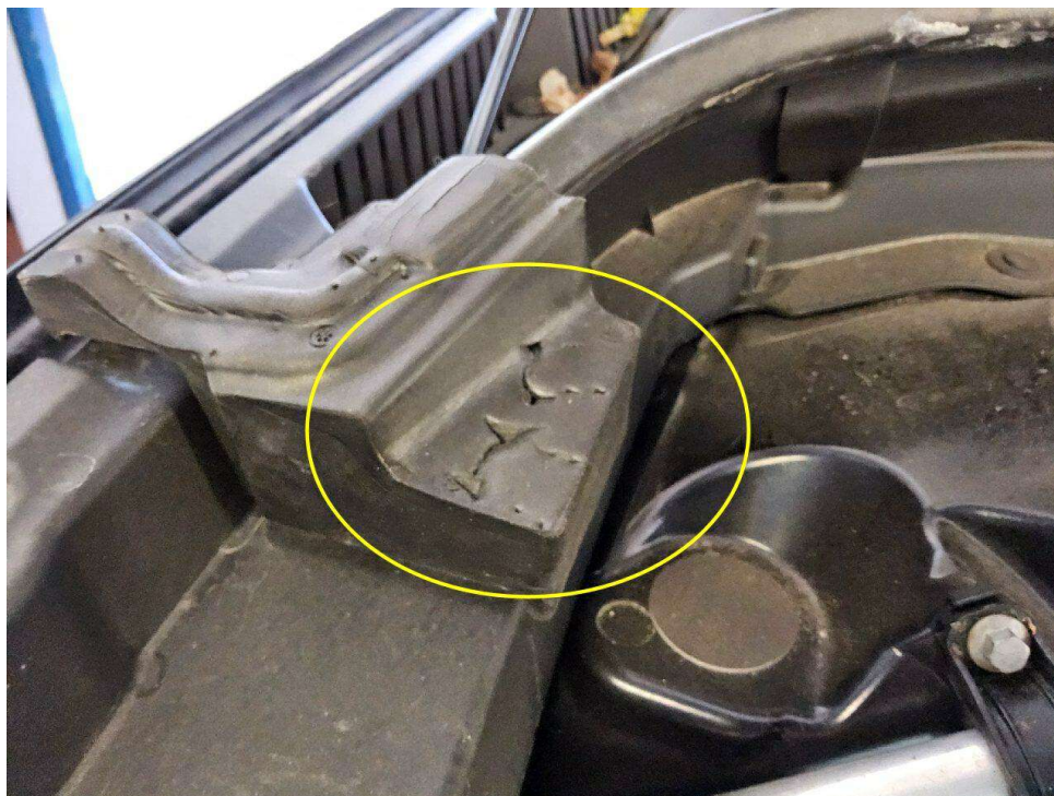
Bild 11 : Motorraumabdichtung links, mittig und rechts Tierversbiss
