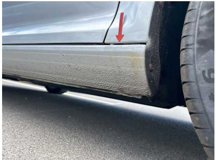
Schweller rechts (Unsachgemäß instand gesetzt, Rost)
