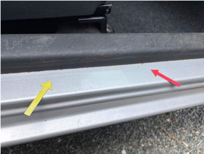
Schweller rechts (Rost)
