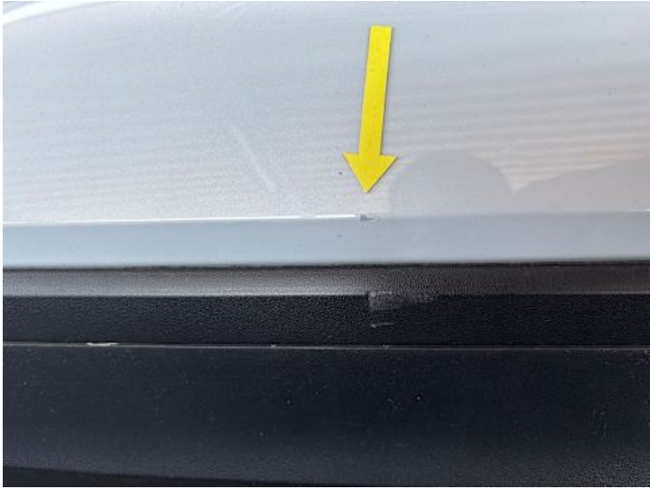
Türe hinten rechts (Kratzer)
