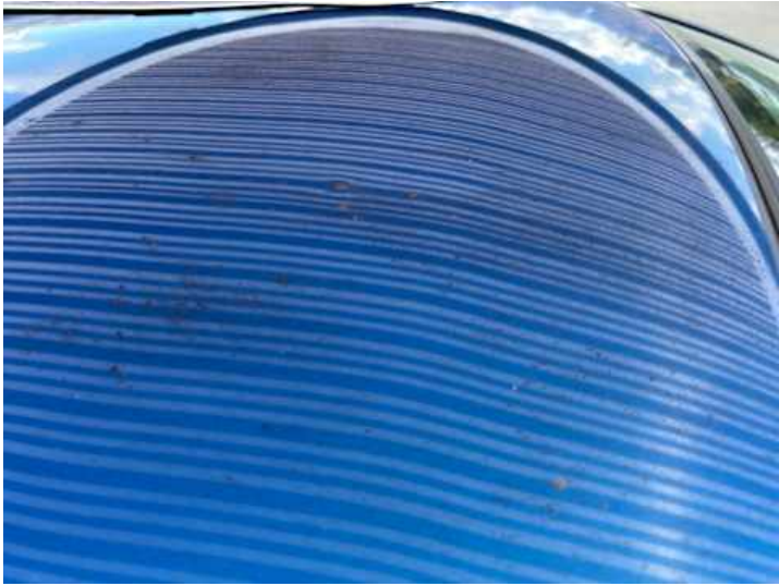
Dach (Delle, Rost)
